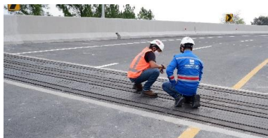
Ispezione ISOSISM® SFX sul viadotto di Sentul Selatan (Indonesia)
