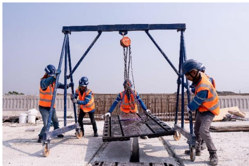
Installazione di giunti ISOSISM® SFX da parte di una squadra specializzata Freyssinet a Jakarta (Indonesia)
