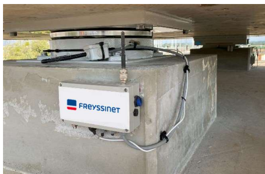
L'appoggio diventa un sensore di carico verticale
