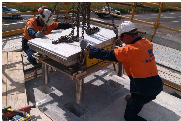
Installazione professionale degli appoggi da parte delle squadre Freyssinet
