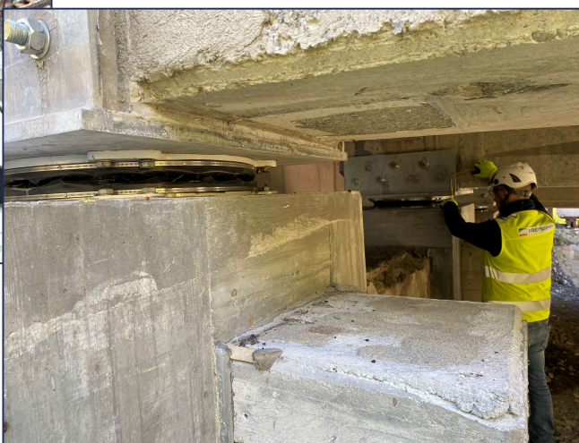
Installazione di ISOSISM® PS da parte delle squadre Freyssinet – esempi di progetti di nuova costruzione e retrofit
