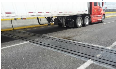
ISOSISM® SFX sotto carichi di traffico pesante - Viadotto di Puebla (Messico)
