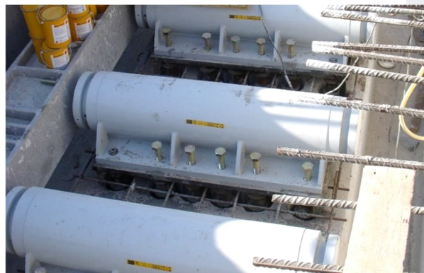
Esempio di dispositivi installati prima del fissaggio delle piastre di scorrimento a un telaio in acciaio
