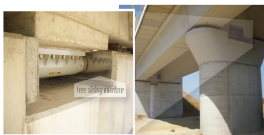
ISOSISM® PDS trasversale sul ponte di Portbou, Spagna
