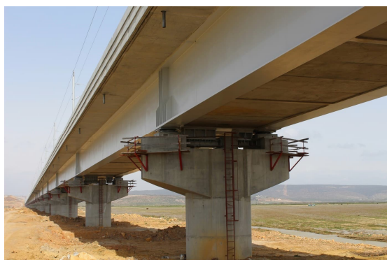
Pile con ISOSISM® PDS e FD trasversali - ponte Loukkos, Marocco
