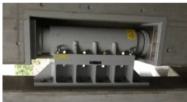
Esempio di installazione di dispositivo completato
