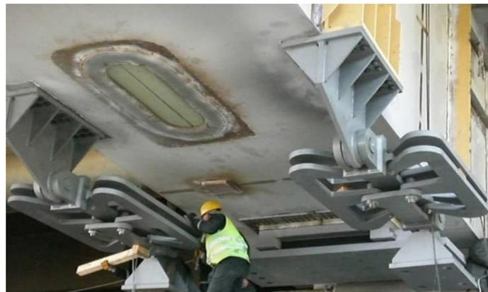
Ammortizzatori ISOSISM® DDD installati su un ponte in acciaio
