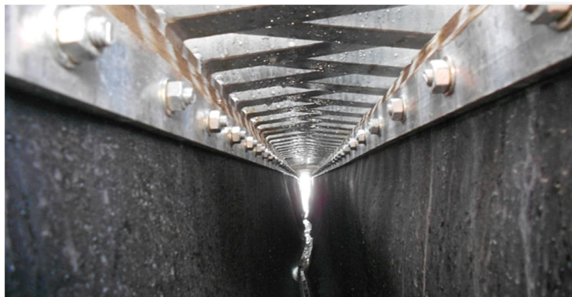
Vista ravvicinata della membrana elastomerica per WP500 – Abidjan Riviera Marcory
