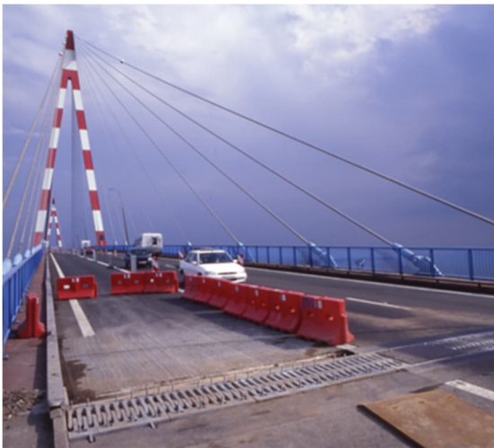
WP 500 in fase di installazione, strada con 1/2 carreggiata chiusa (ponte Saint-Nazaire, Francia)
