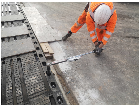
Serraggio ancoraggi del giunto Multiflex SX350
